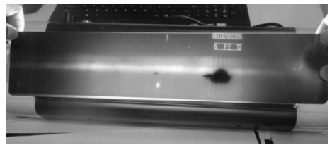
(b) 环焊缝开裂
