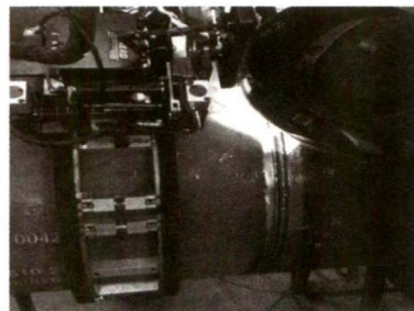
图 2 焊接过程照片
