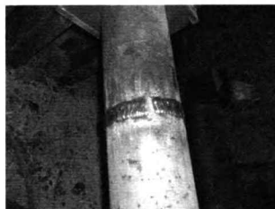
图7 焊条电弧焊填充后的焊缝形貌
