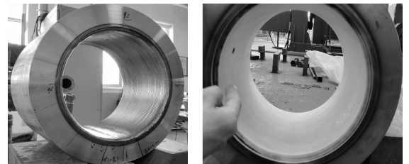
(a)内壁堆焊
