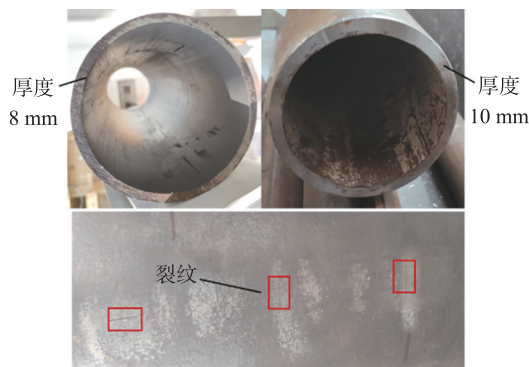
图 14 被检测的压力管道
