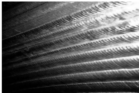
(b) 组焊顶部焊接照片
