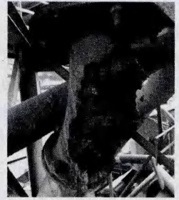
(c) 陕西某硫铁矿改造工程
