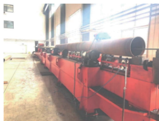
(a) 管道堆焊实物图
