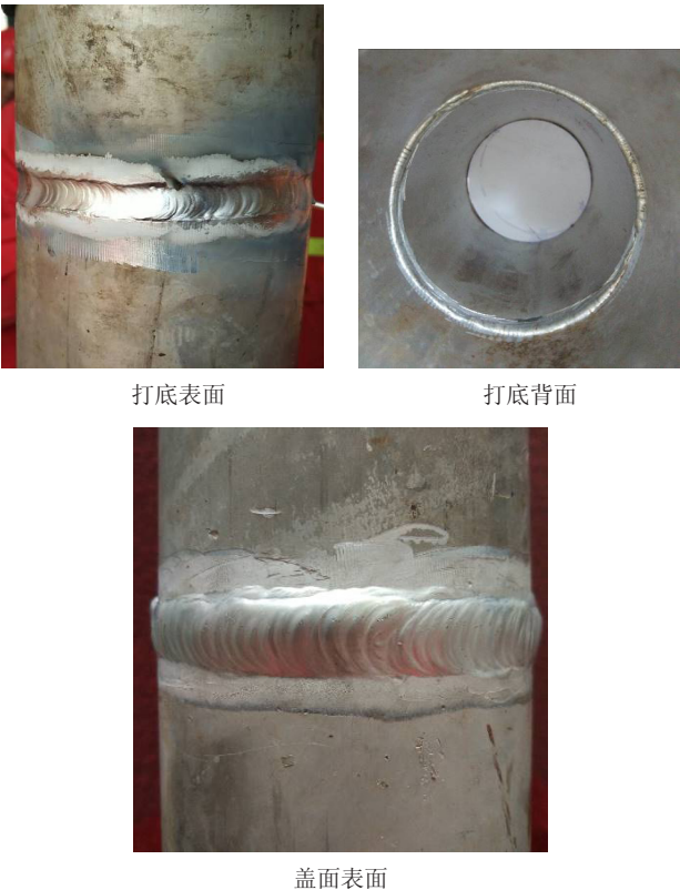
图3 焊接后打底及盖面的外观成形
