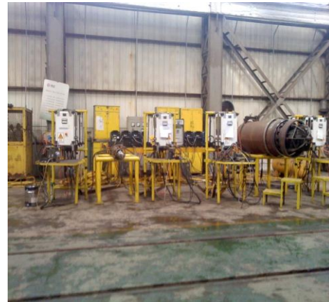
图3 双车双丝管道全位置自动焊接系统
