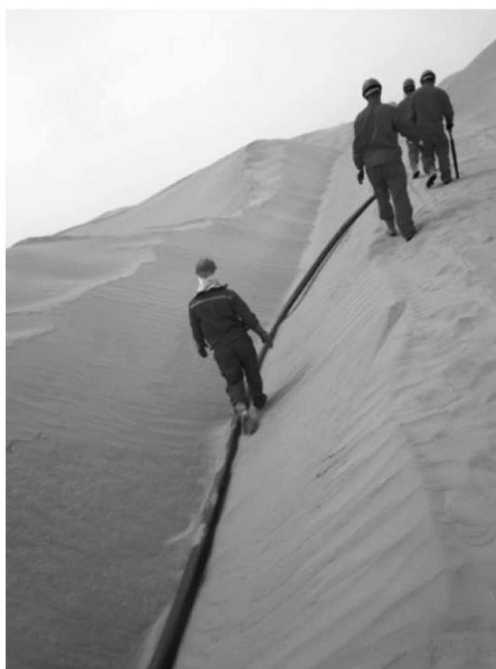
图 12 抗硫非金属管现场应用
