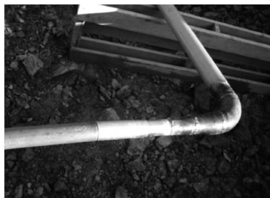
图 10 热塑性柔性管焊接到钢管道
