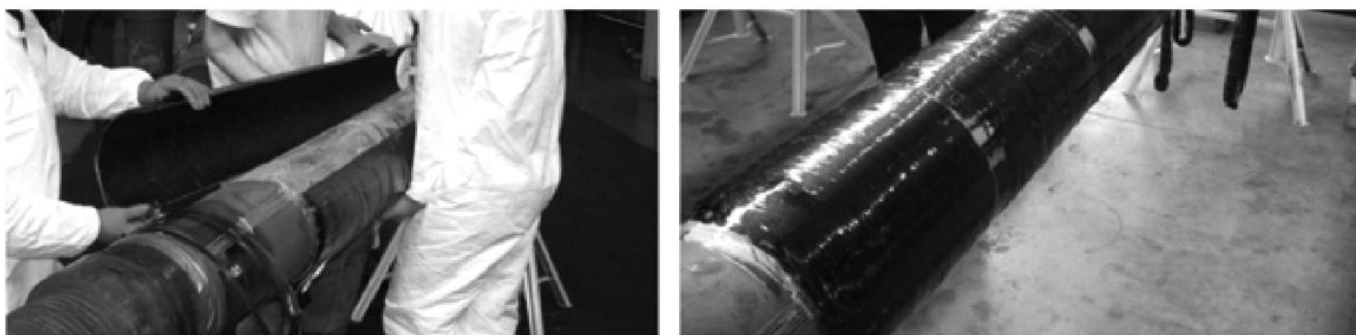
图 15 碳纤维增强复合材料修复海上钢质立管
