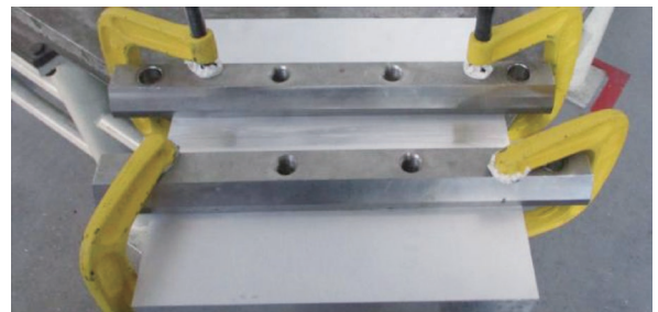
图 1 试件焊接工装及装配情况
