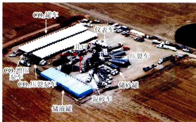
图4 CO 2 泡沫压裂现场施工图
